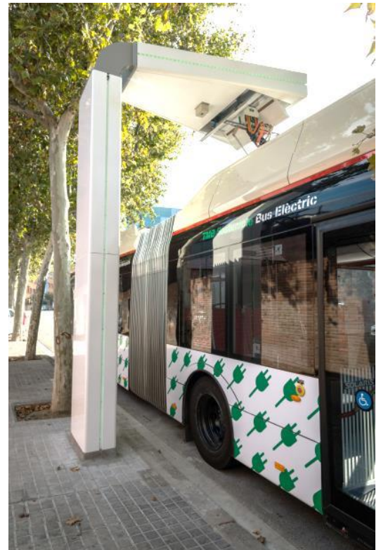
Autobús estacionado bajo el cargador de vehículos pesados de la calle Cisell
