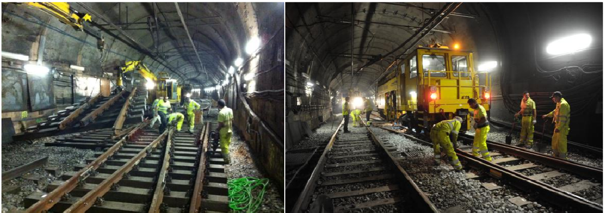
Muntatge de la diagonal i condicionament del tram de via a Cornellà Centre.
