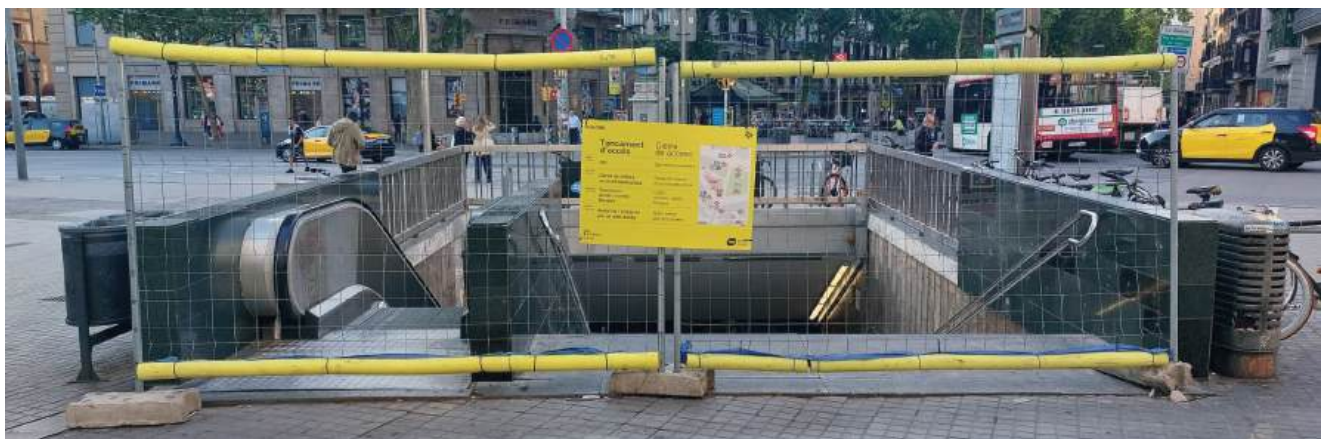
Imatge d'una entrada tancada amb cartells grocs
