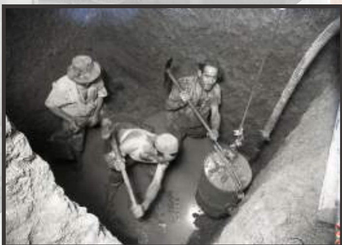
Foto dels treballs de construcció a la Marina l'any 1959.
