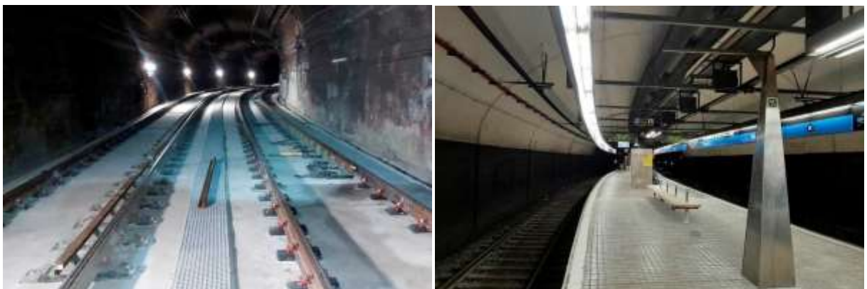
Via renovada al tram La Sagrera – Congrés de l'L5 de metro. A la dreta, l'estació de Maragall un cop retirat l'aplatat de fibrociment
