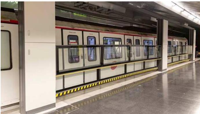
Módulos de puertas de andén verticales instalados en el metro de Barcelona para la prueba piloto
